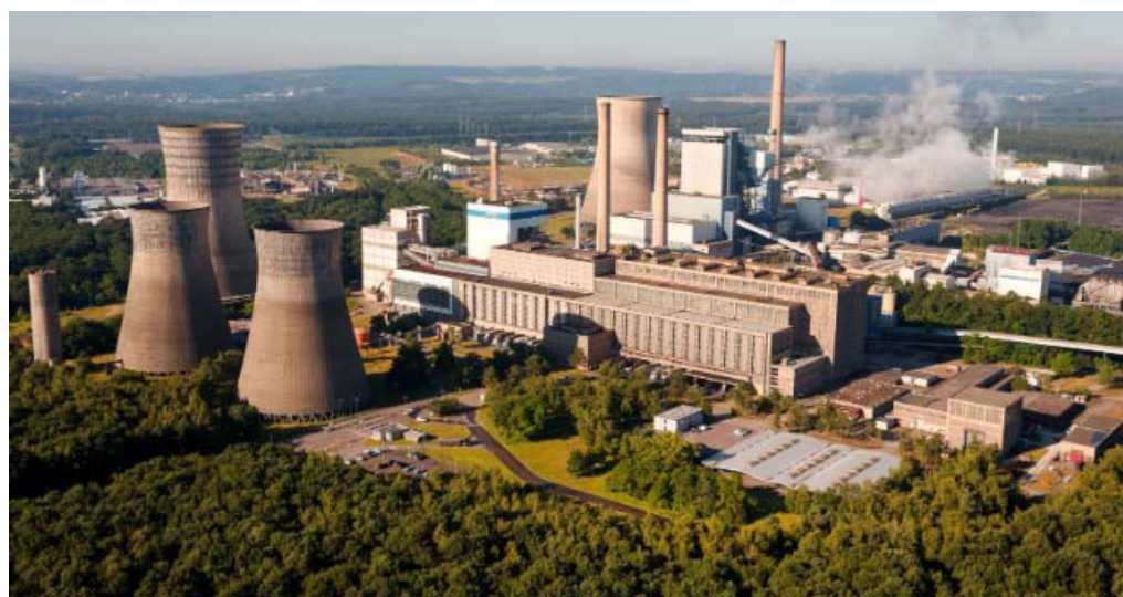
Figure 16 : Vue d'ensemble de la Centrale Émile Huchet
