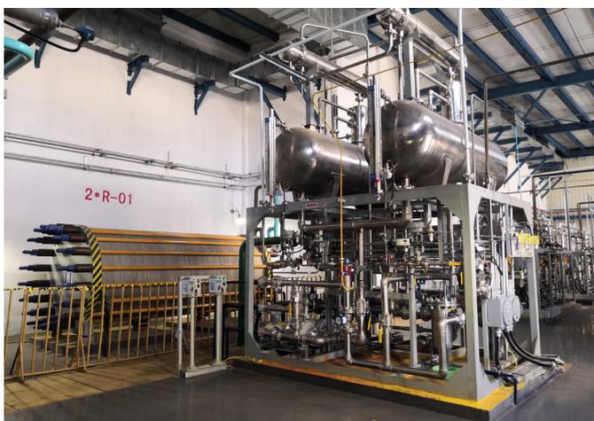
Figure 12 : Electrolyseur Alcalin 5MW + Unité de séparation gaz/liquide – Copyrights “John Cockerill”
